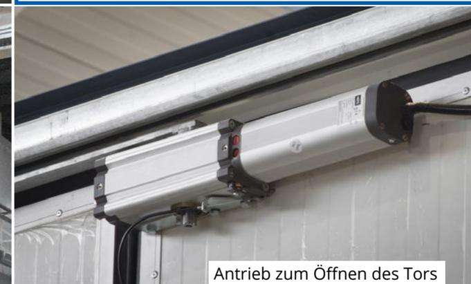
Antrieb zum Öffnen des Tors
